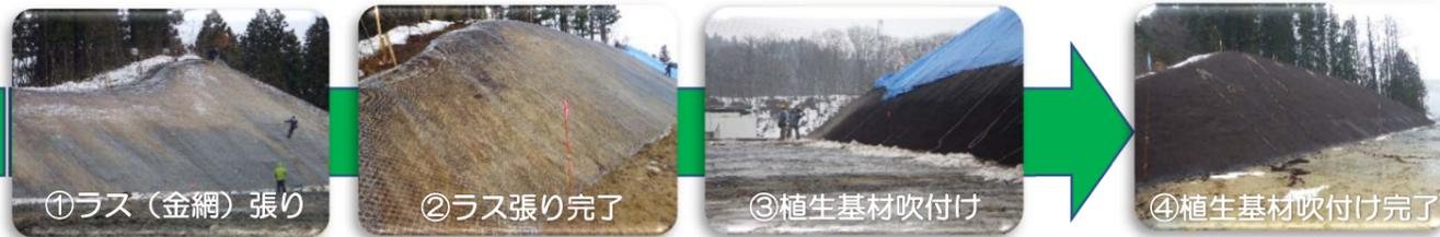
★現在の施工は、除雪作業を行いながら**路体盛土**・**排水構造物工**を行っています。路体盛土は1月15日より約1カ月程度、大型ダンプトラック（5台）にて升形ICの残土仮置場から現場まで**土砂運搬**を行いながら施工しています。ダンプトラックの背面に工事を識別するためのプレートをつけていますので、何かお気づきになりましたら、下記現場事務所までご連絡下さい。
