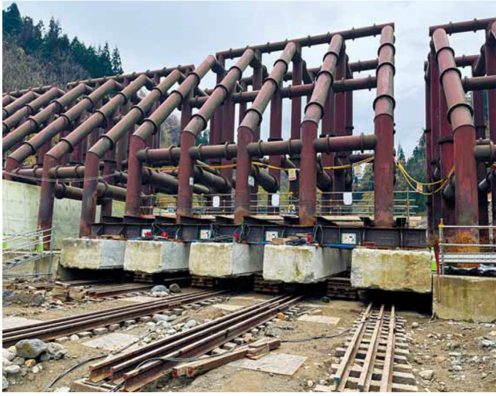
移設完了(下流側)
