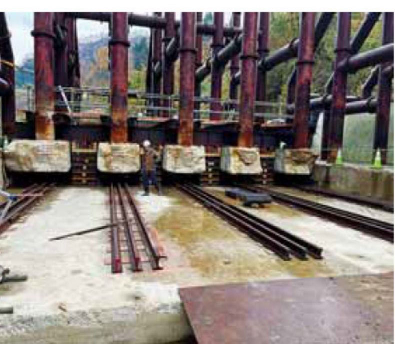
道レール設置完了
